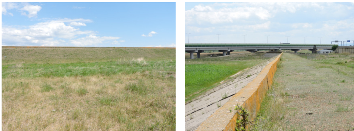
Figura 61. Digul de protecție existent în vecinătatea ITDCS
