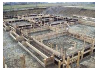
Stația de transfer, sortare, compostare Onești:
